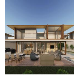
AVALON Residencial Bétera 7 unidades
