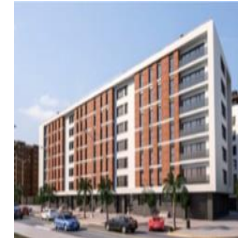
AIRA Residencial Castellón 60 unidades
